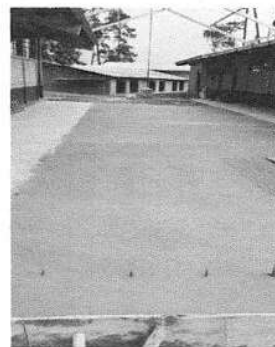
Foto 2: Suministro e instalación de entortado de área de 95m2.
