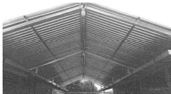
Foto 4: Suministro e instalación de techo para pasillo de aulas con láminas troqueladas Aluzinc calibre 26
