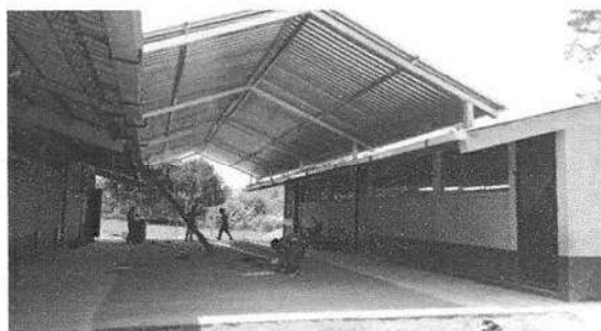
Foto 5: Instalación de canales
